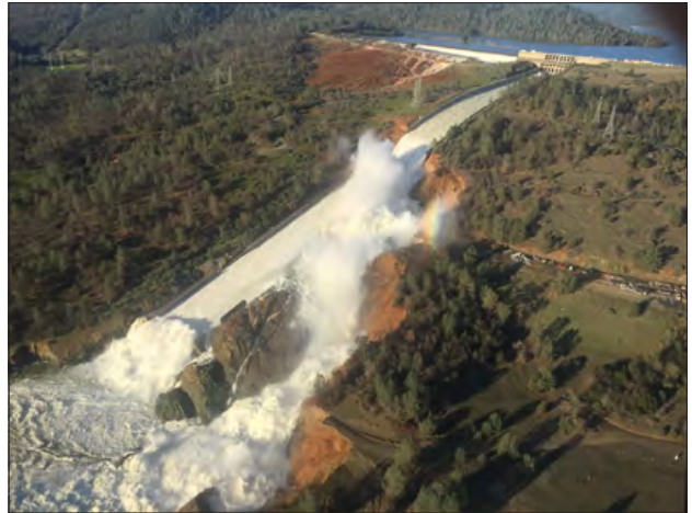
Slika 24: Erozija ob strani prelivnega polja na jezu Oroville v Kaliforniji februarja (vir: DWR Acting Director William Croyle, floodlist.com)
