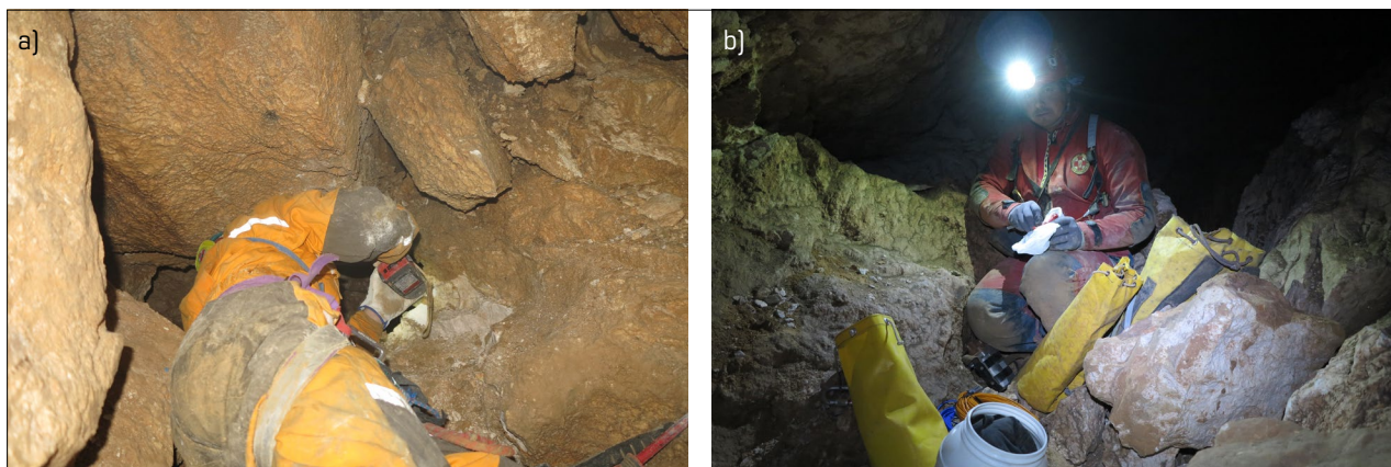
Slika 7: a) vrtanje izvrtine premera 12 mm z baterijskim vrtalnim strojem in b) prepakiranje eksploziva iz originalne embalaže v PVC cevke. (foto: M. Merela)
