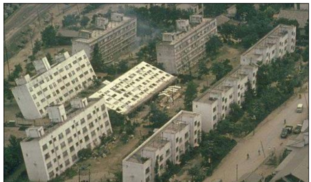
Slika 1: Posledice likvifakcije po potresu 1964 v Niigati (Japonska). Stanovanjski bloki so se pogreznil, nagnili ali prevrnili. (vir: Wikipedia)
