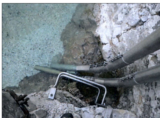
Slika 3: Merilnik motnosti je nameščen v cevi. (foto: Arhiv ARSO) Figure 3: The turbidity meter installed in the pipe. (Source: ARSO Archives)
