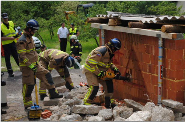
Slika 1: Pripadniki državne enote MUSAR so se morali do poškodovanca prebiti tako, da so v steno naredili veliko luknjo. (foto: B. Kuntarič)
