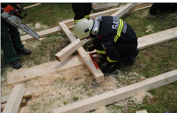
Slika 3: Gasilci so morali podpreti dele nekaterih objektov, da ne bi njihovi padajoči deli poškodovali ljudi in reševalcev, ki so hodili med njimi. Najprej so morali sami izdelati ustrezno leseno konstrukcijo. (foto: B. Kuntarič)
