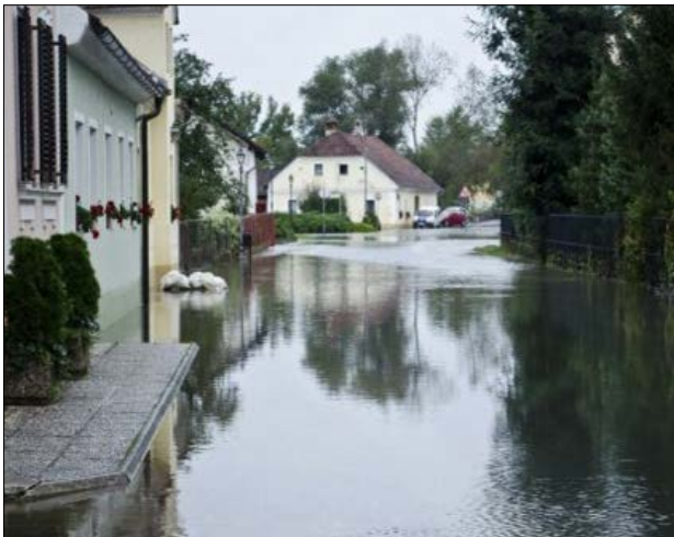
Slika 7: Poplavljene ceste v Kostanjevici 16. oktobra 2015 (vir: zurnal24.si)
