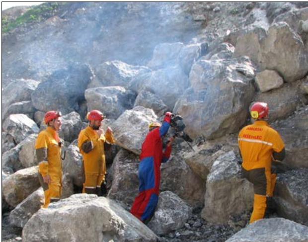
Slika 5: Načini vrtanja vrtin premerov med 8 in 12 mm; a) vrtanje z bencinskim vrtalnikom na dobro zračenem kraju in b) vrtanje z baterijskim vrtalnikom v jami (foto: M. Merela)
