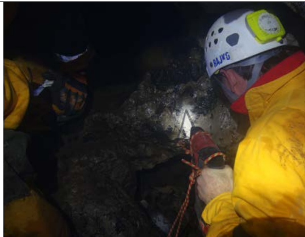
Slika 5: Načini vrtanja vrtin premerov med 8 in 12 mm; a) vrtanje z bencinskim vrtalnikom na dobro zračenem kraju in b) vrtanje z baterijskim vrtalnikom v jami (foto: M. Merela)
