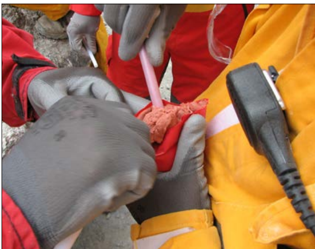
Slika 6: a) prepakiranje eksploziva iz originalne embalaže b) PVC-patrone, premera 10 mm, ki omogočajo optimalno polnjenje vrtin majhnih premerov do 12 mm (foto: M. Merela)
