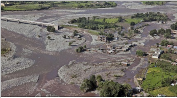
Slika 17: Poškodovan most na reki Betar v kraju Poonch na SZ Indije v začetku septembra (vir: breakingnewspak.com)
