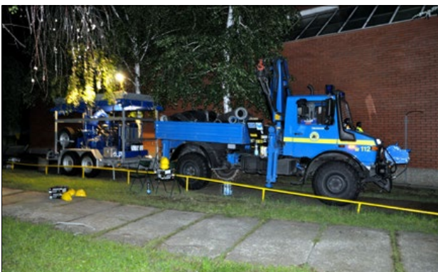
Slika 3: Enota CZ RS z visoko zmogljivo črpalko DIA AVS v termoelektrarni v Obrenovcu (foto: D. Špiljak)
