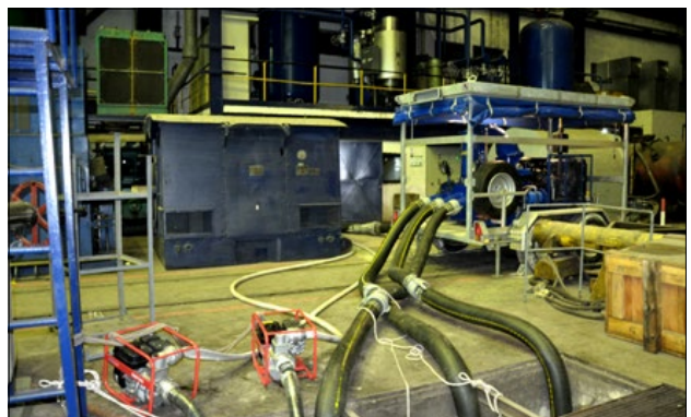
Slika 4: Visoko zmogljiva črpalka DIA AVS je bila nameščena tudi v termoelektrarni. (foto: D. Špiljak)
