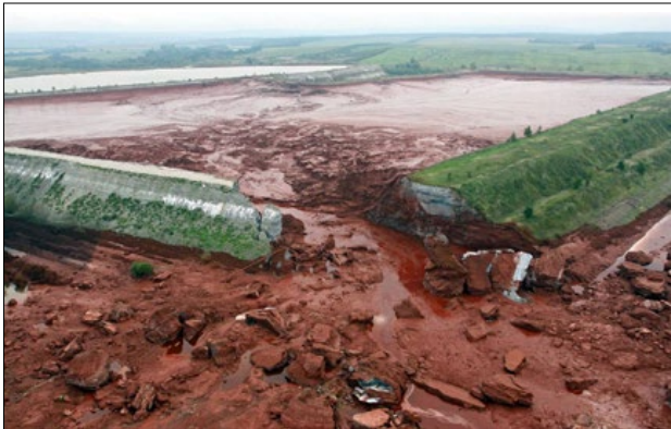
Slika 10: Pogled z južne strani na zadrževalnik št. 10 v Ajki z vidno odprtino na severozahodnem vogalu. Viden je zahodni nasip z vmesno bermjo in površinsko ozelenitvijo (vir: Ajka accident, http://commons.wikimedia.org/wiki/File:Ajka_accident_7b9017f332_b.jpg ).
