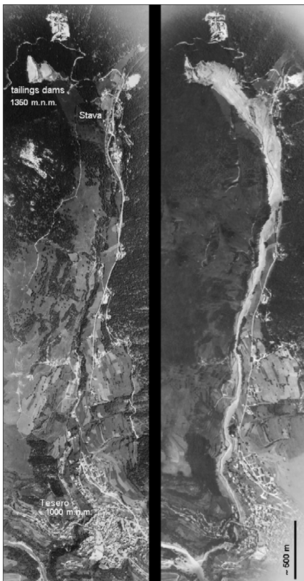
Slika 5: Pogled na dolino Stava pred blatnim tokom in po njem zaradi porušitve jalovinskih pregrad (vir: WISE Uranium Project, The Stava tailings dam failure (Trento, Italy), http://www.wise-uranium.org/mdafst.html )
