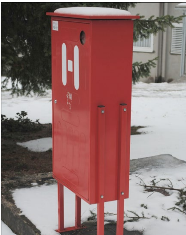
Slika 3: Za boj z ognjem so postavljene hidrantne omarice, v katerih so tudi cevi za vodo. (foto: B. Kuntarič)
