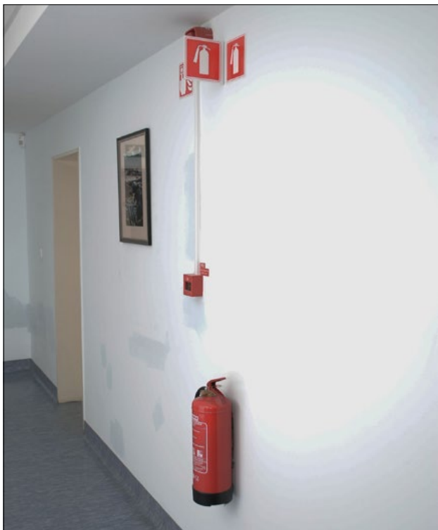
Slika 1: Objekti SV so v notranjosti opremljeni z gasilniki, aktivno požarno zaščito in svetlobnimi telesi, ki kažejo smer evakuacije. (foto: B. Kuntarič)
