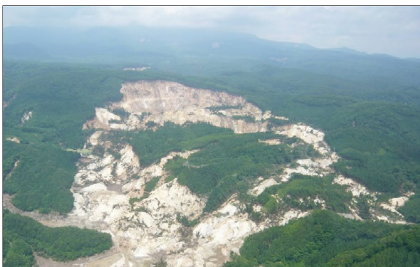
Slika 3: Zračni posnetek katastrofalnega globokega zemeljskega plazu Aratozawa v zaledju mesta Kurihara v prefekturi Miyagi na Japonskem (foto: Google Maps, marec 2015)
