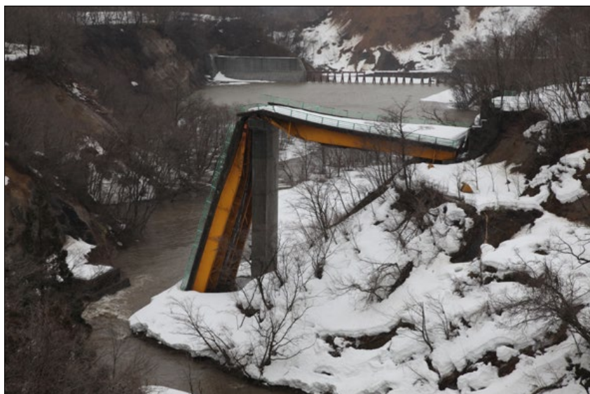
Slika 6: Neobnovljen porušeni most na nacionalni cesti 342, ki povezuje kraj Ichinoseki v prefekturi Iwate na vzhodni strani otoka Honšu s prefekturo Akita na zahodni strani otoka Honšu na Japonskem (foto: M. Mikoš, marec 2015)
