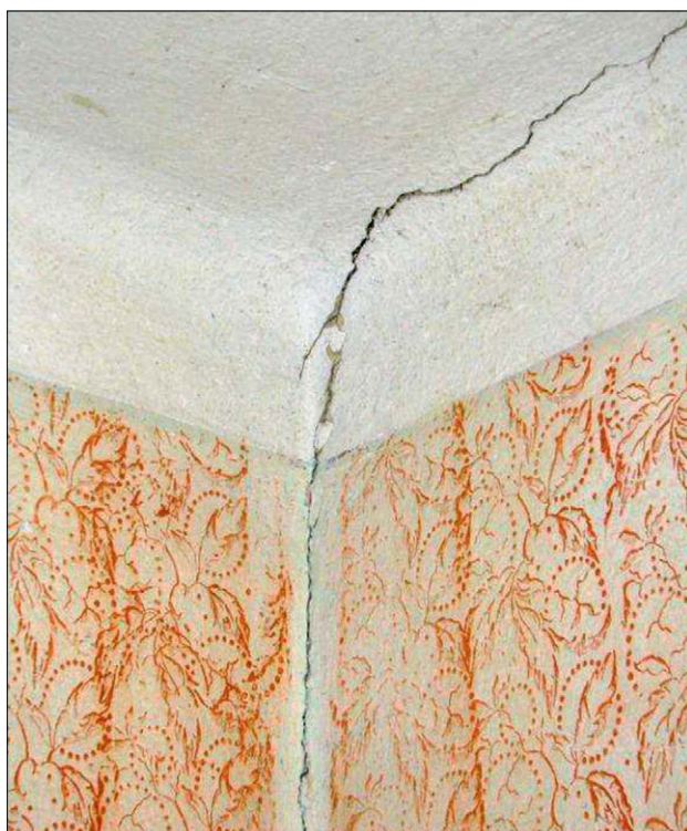
Slika 6: Poškodbe druge stopnje na zgradbi v Hinjah, ki so nastale ob potresu 16. junija 2013
