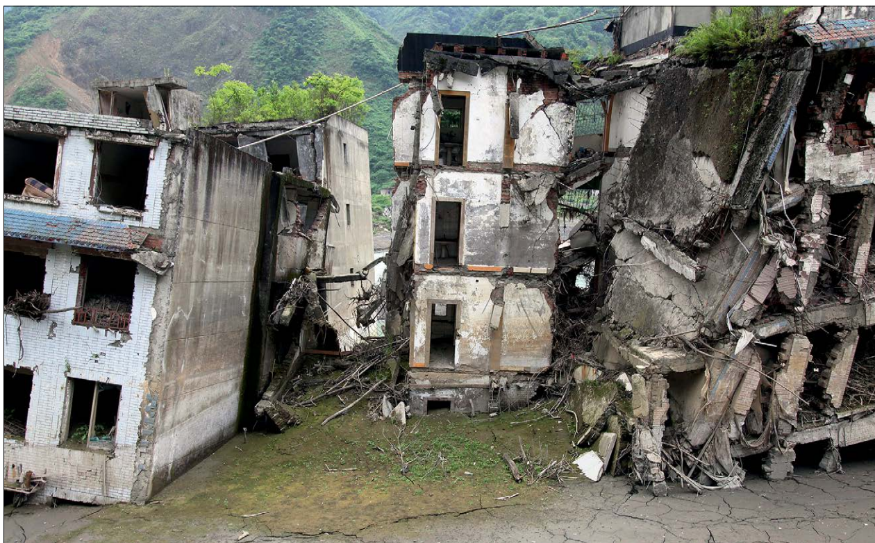
Slika 7: Uničeni objekti v mestu Qushan ob wenchuanskem potresu 12. maja 2008, ki jih je 24. septembra 2008 tudi do 10 metrov na visoko zasul še drobirski tok (foto: M. Mikoš, junij 2014)
