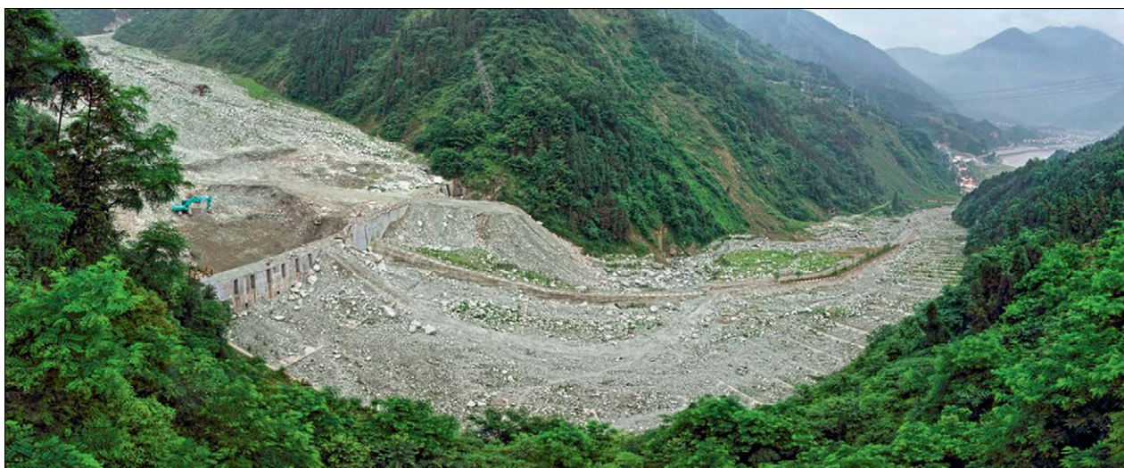
Slika 6: Zasuta dolina hudournika Niujuan v bližini mesta Yingxiu v provinci Sečuan na jugozahodnem delu Kitajske. V sredini slike je viden nagnjen steber daljnovoda. (foto: www.mergili.at, junij 2014)
