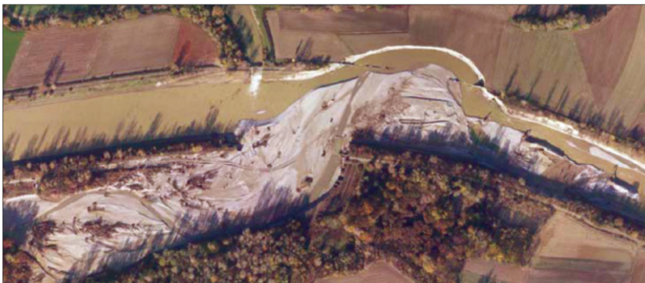
Slika 19: S sedimenti zasut odvodni kanal HE Formin – ORTOFOTO 9. november 2012 (Mensuras, d. o. o.)
