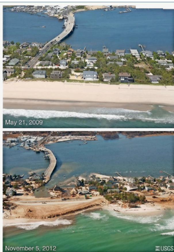
Slika 15: Škoda na obali zaradi hurikana Sandy v kraju Mantoloking v New Jerseyju. Primerjava stanja 21. maja 2009 in 5. novembra 2012, ko je Sandy že zapustila območje. (vir: USGS)
