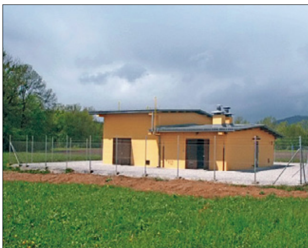
Slika 1: Merilno-regulacijska postaja (MRP) za zemeljski plin Figure 1: Example of a metering-regulation station (MRS) for natural gas.
