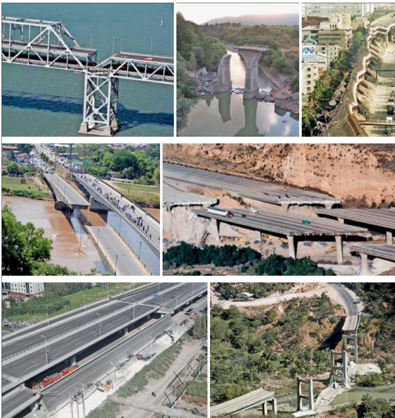
Slika 7: Primeri porušenja mostov
