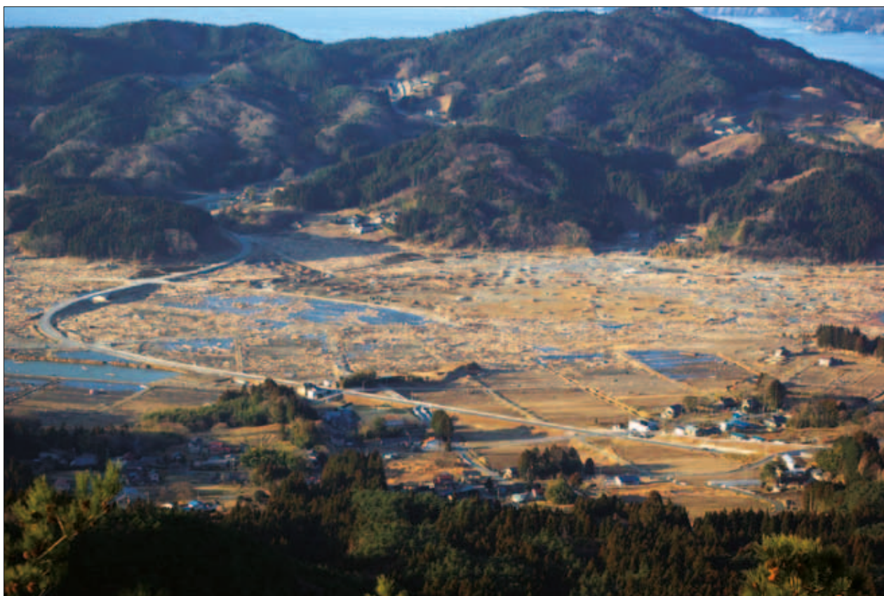
Slika 9: Uničenje zaradi cunamija na območju Rikuzentakata Figure 9: Tsunami destruction in the Rikuzentakata area.
