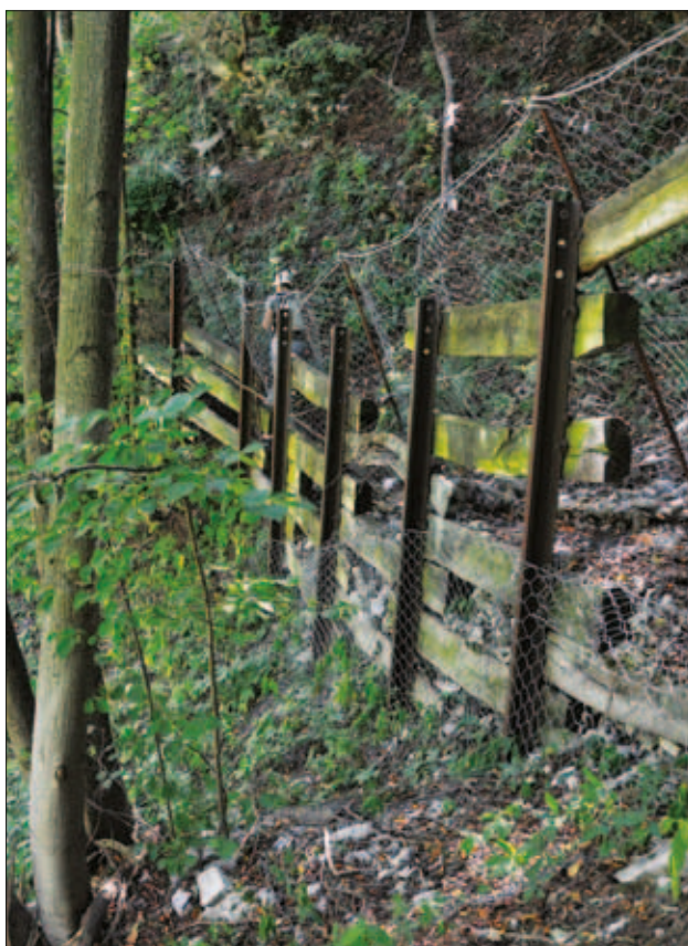
Slika 6: Značilna vrsta in stanje sedanjih zaščitnih objektov (foto: G. Novak)
