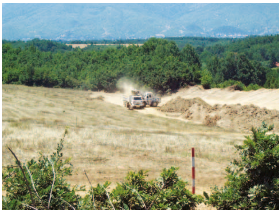
Slika 19: Odstranjevanje vrhnjega sloja zemlje je pri razminiranju dokaj pogosto. Delovišče NGO Halo Trust, Kosovo 2000 (foto: arhiv MACC)
