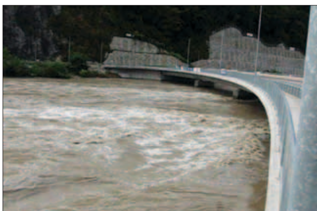
Slika 8: Zožen prečni profil na Savi (dolvodno od gradbišča nove HE Krško) povzroči prehiter in preveč valovit tok, kar onemogoča uspešno izvedbo meritve. (foto: M. Burger)
