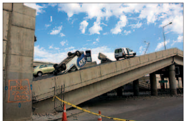
Slika 4: Avtocesta Vespucio Norte v Čilu po potresu 27. februarja 2010. (vir: http://en.wikipedia.org/wiki/File:Vespucio_Norte_Highway_after_2010_earthquake.jpg )
