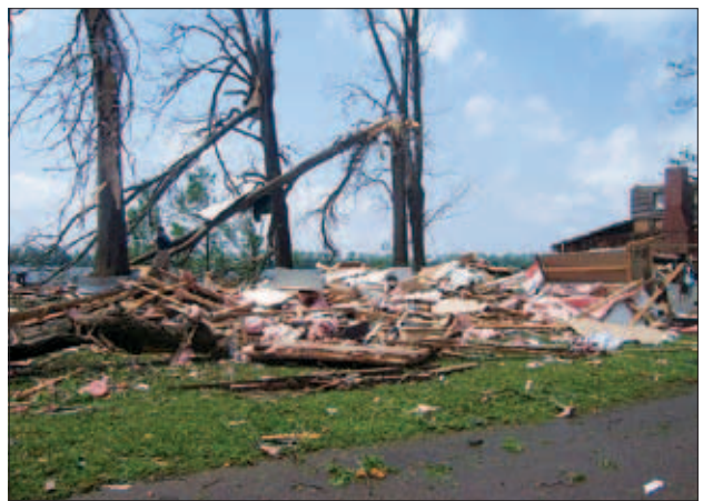
Slika 8: Škoda zaradi enega izmed tornadov v Misisipiju med izbruhom tornadov med 22. in 24. aprilom (vir: National Weather Service Jackson, Mississippi)
