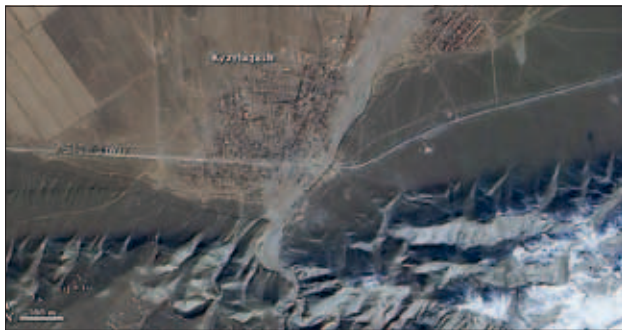
Slika 5: Posledica porušitve jezua v mestu Kyzylagash (vir: EO, 2010)
