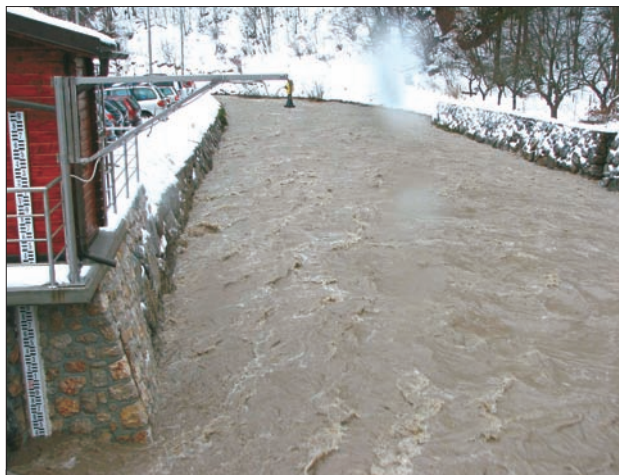
Slika 18: Največji pretok Selške Sore v Železnikih je imel v decembrski povodnji 5–10-letno povratno dobo. (foto: R. Trček)
