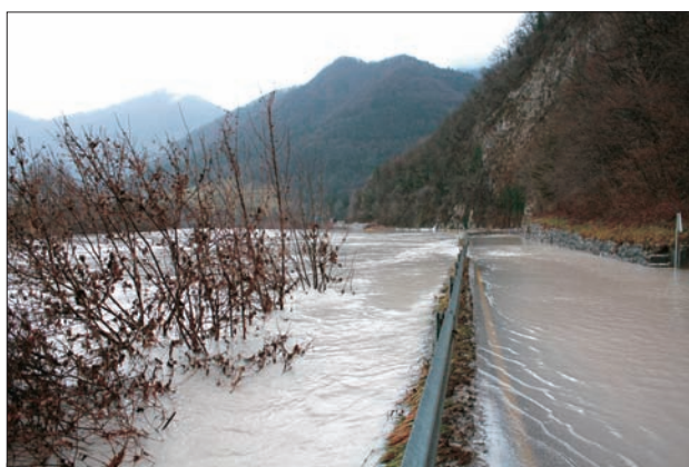
Slika 16: Glavna cesta Tolmin-Most na Soči, ki je sicer 2,5 m nad gladino akumulacije (25. decembra 2009 ob 15.15) (foto: M. Kogoj)
