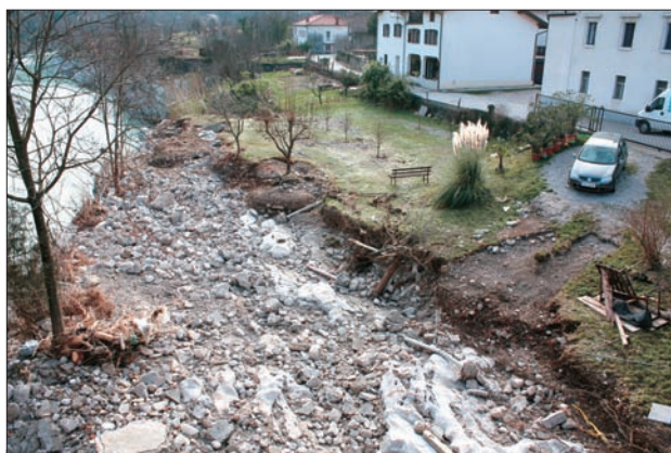
Slika 8: Do koder je voda segla, je prst odplavljena (29. december 2009). (foto: M. Kogoj) Figure 8: Erosion where the water reached the soil (29 December 2009). (photo: M. Kogoj)
