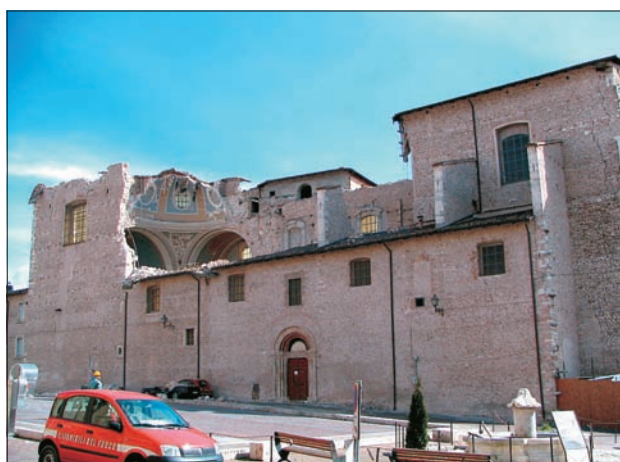
Slika 2: L'Aquila. V cerkvi Santa Maria di Paganica sta se porušili streha in kupola. Cerkev je bila zgrajena že v XIV. stoletju, potres leta 1703 jo je porušil, zato je bila v XVIII. stoletju skoraj v celoti na novo zgrajena. (foto: M. Godec)
