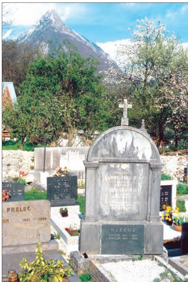
Slika 7: Zasuk nagrobnika na pokopališču v Bovcu ob potresu leta 1998 (foto: A. Gosar)
