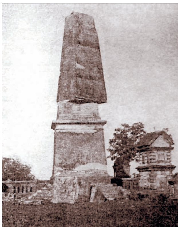
Slika 5: Zasuk segmentov obeliska zaradi assamskega potresa leta 1897 (Lee in sod., 2009)
