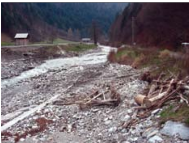
Slika 7. Pogled izpod Dolenčevega jezua gorvodno. Reka si je ustvarila novo niveleto struge, drča pa skoraj ni več vidna in predstavlja le še stabilizacijsko rebro. (foto: G. Rak)
