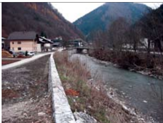
Slika 7. Pogled izpod Dolenčevega jezua gorvodno. Reka si je ustvarila novo niveleto struge, drča pa skoraj ni več vidna in predstavlja le še stabilizacijsko rebro. (foto: G. Rak)
