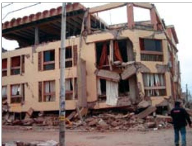
Slika 4. Armiranobetonska konstrukcija hotela Embassy v kraju Pisco se je porušila zaradi krhkega loma stebrov v pritličju.
