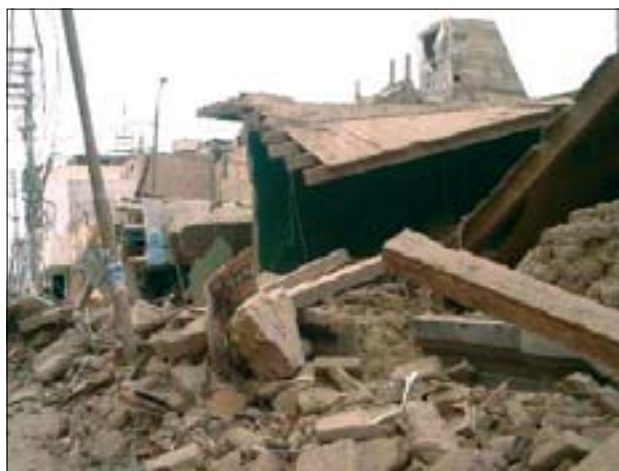
Slika 3. Značilna porušitev hiš, zgrajenih iz na zraku sušene opeke (adobe). Tovrstne poškodbe so prevladovala v krajih Pisco, Ica in Chinchu Alta.
