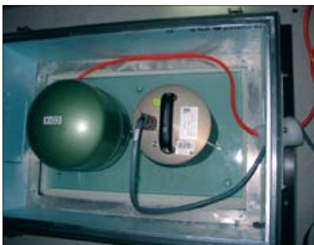
Slika 6. Zadnja kontrola pred nastavitvijo izolacijskega pokrova.
