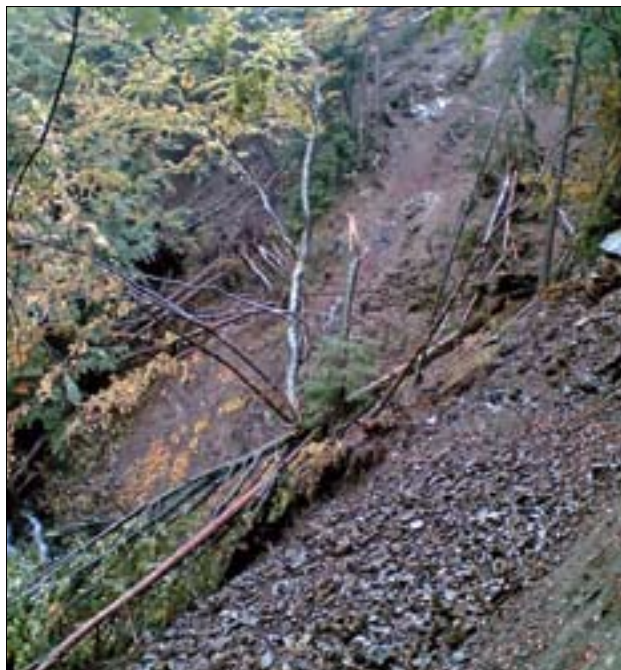
Slika 1. Zemeljski plaz nad Kropo Figure 1. Landslide above Kropa
