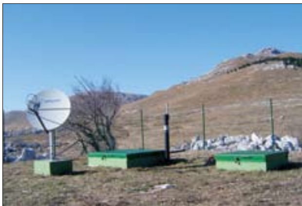
Slika 5. Na potresnih opazovalnicah v odročnih krajih je uporabljen satelitski prenos podatkov.
