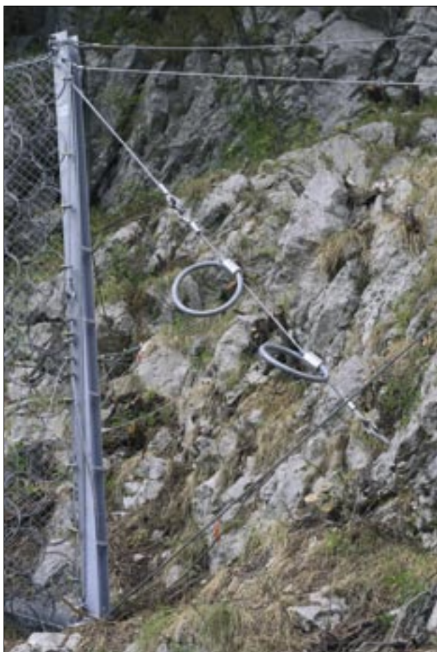
Slika 4. Zavorni obroči na nosilnih jeklenih vrveh, ki so pritrjene na stranska vrvna sidra (foto: P. Savnik)
