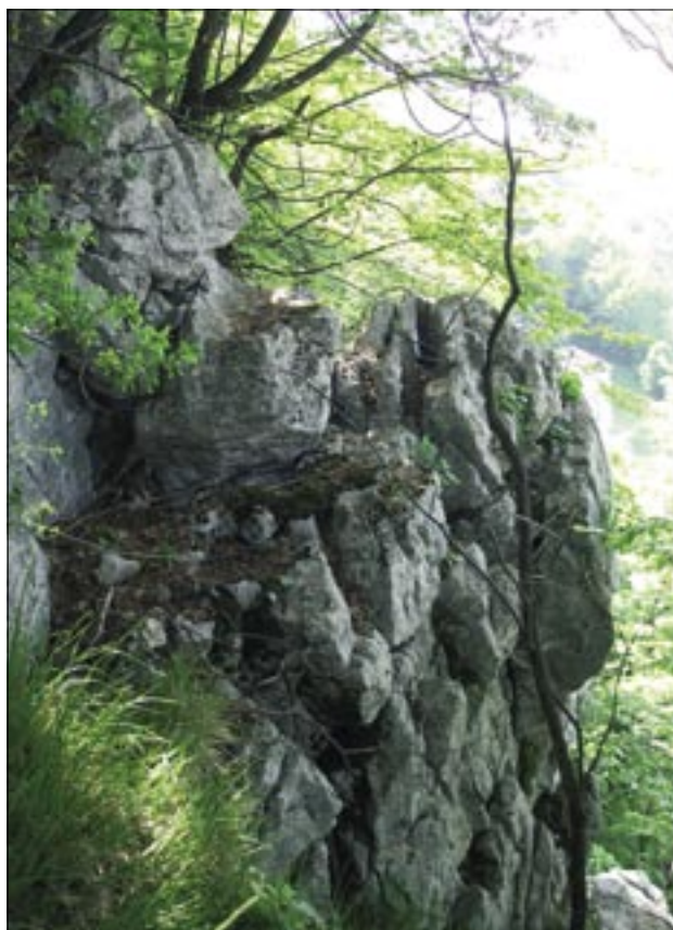
Slika 2. Razpokana kamnina na pobočju nad regionalno cesto (foto: M. Koren) Figure 2. Decaying rock aggregate on the slope above the regional road (photo: M. Koren)
