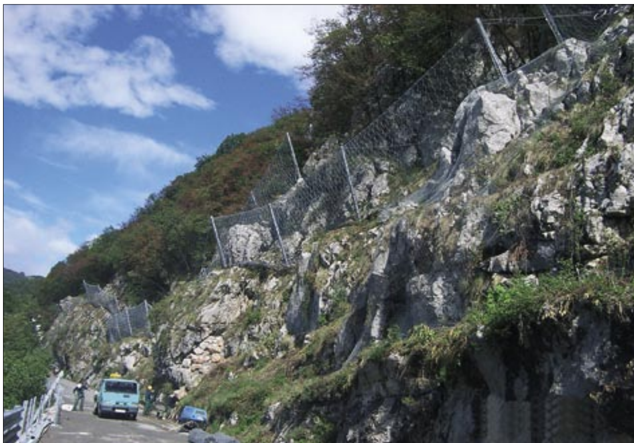
Slika 9. Pobočje nad regionalno cesto po izvedbi lovilnih podajnih ograj (foto: A. Rus)
