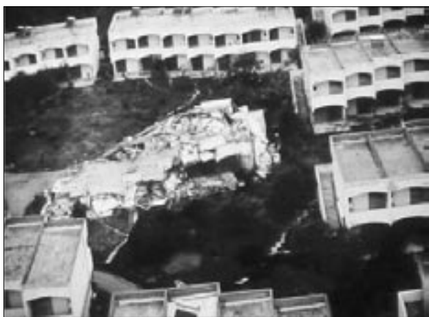
Slika 1. Porušitev le ene zgradbe med številnimi enakimi je predvsem posledica resonančnih učinkov med sedimenti in zgradbo. Potres leta 1985 v Kalamati (Grčija).
