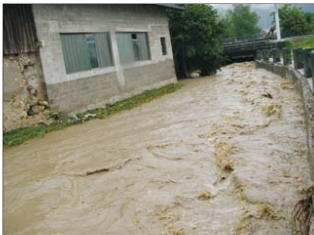
Slika 6. Na gradbenem objektu vidna sled najvišje vode Sevnične v Sevnici dne 21. 8. 2005 ob 12.38 (foto: J. Uhan) Figure 6. Traces visible on a building, of the highest waters of the Sevnična in Sevnica on 21.8.2005 at 12.38 (photo: J. Uhan)
