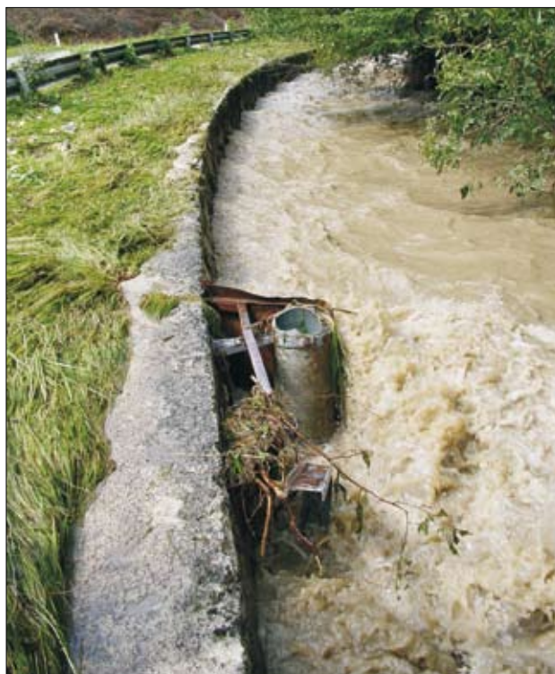
Slika 7. Stanje na vodomerni postaji Orešje na Sevnični 22. 8. 2005 (foto: M. Burger) Figure 7. Situation at Orešje water measuring station on the Sevnica on 22.8.2005 (photo: M. Burger)
