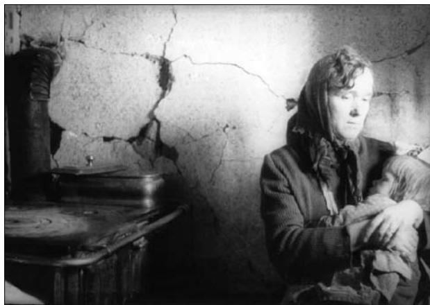
Slika 3. Ob potresu 31. januarja 1956 z magnitudo 5,1 in največjimi učinki VII. stopnje po lestvici EMS so nastale številne poškodbe (arhiv Urada za seizmologijo in geologijo).
