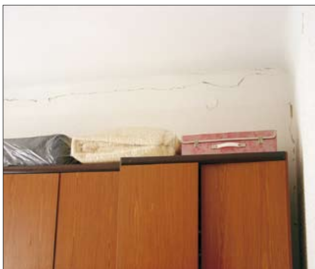
Slika 10. Pogled na stanovanjsko hišo na Gubičevi 18 v Ilirski Bistrici, kjer so nastale globoke razpoke na stiku stene s stropom in sosednjimi stenami (na stikih nepovezanega zidovja in stropne konstrukcije nastajajo razpoke, ki so značilne za starejše zidane objekte z lesenim stropom; do poškodb je prišlo, ker ni bilo nikakršne povezave posameznih konstrukcijskih elementov).
