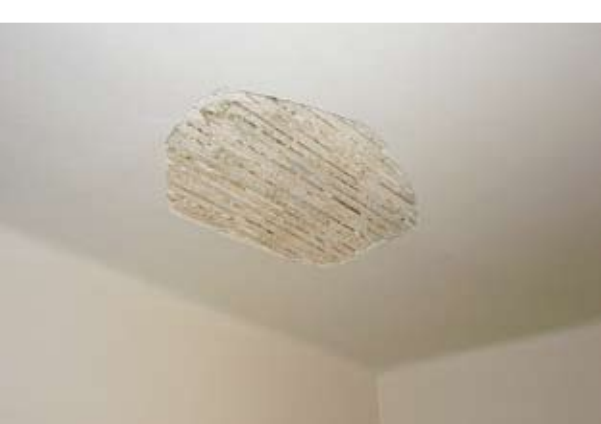
Slika 12. Starejša zgradba v Ilirski Bistrici (Titov trg 3), z delno odlomljenim dimnikom. V objektu je prišlo tudi do delnega odpadanja ometa s stropov.
