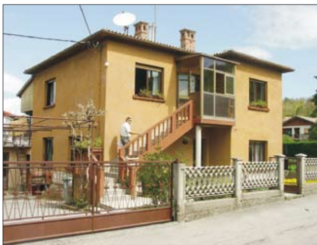
Slika 13. Stanovanjska hiša na Šercerjevi 7 v Ilirski Bistrici s poškodovanima dimnikoma. V notranjosti so na lesenem stropu nastale razpoke, ki so pogosta posledica obnašanja starejših objektov med potresi (nepovezavo zidovje, leseni strop).
