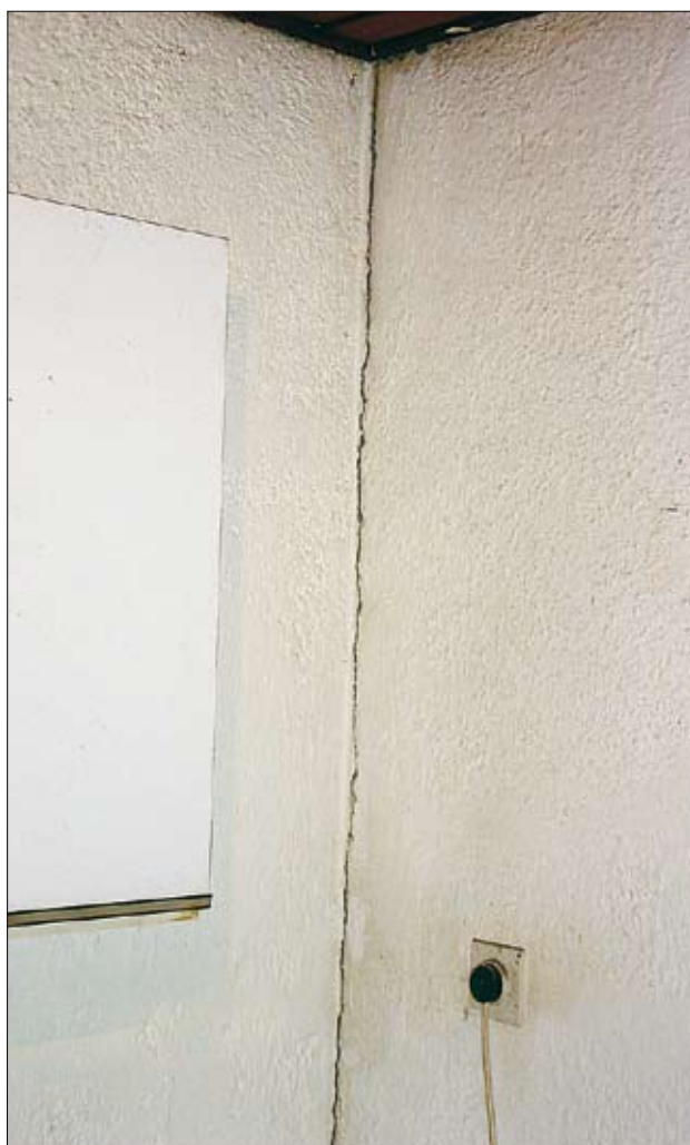
Slika 13. Stanovanjska hiša na Šercerjevi 7 v Ilirski Bistrici s poškodovanima dimnikoma. V notranjosti so na lesenem stropu nastale razpoke, ki so pogosta posledica obnašanja starejših objektov med potresi (nepovezavo zidovje, leseni strop).
