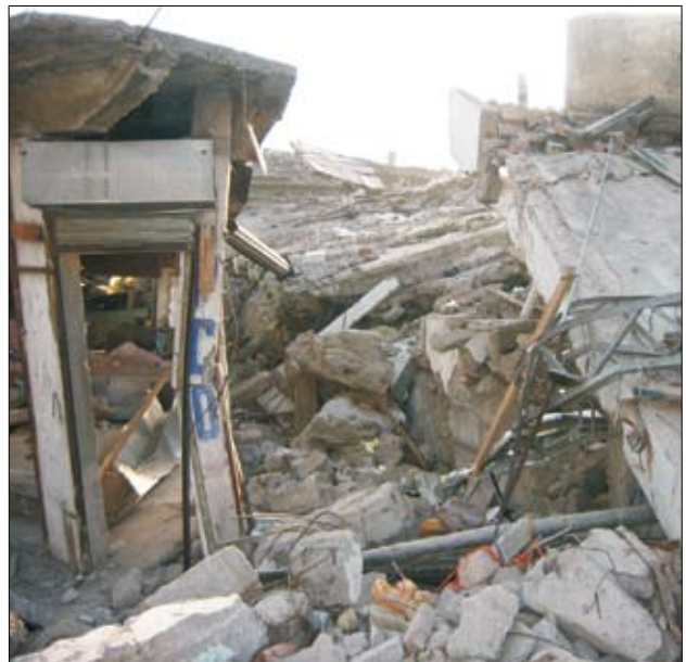
Sliki 17. Balakot: do nerazpoznavnosti porušena armiranobetonska konstrukcija.
