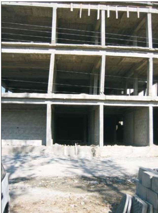
Sliki 13. Prehod iz pritličja, kjer je okvirna konstrukcija zapolnjena z zidanimi polnili, v prvo nadstropje. Detajl.
