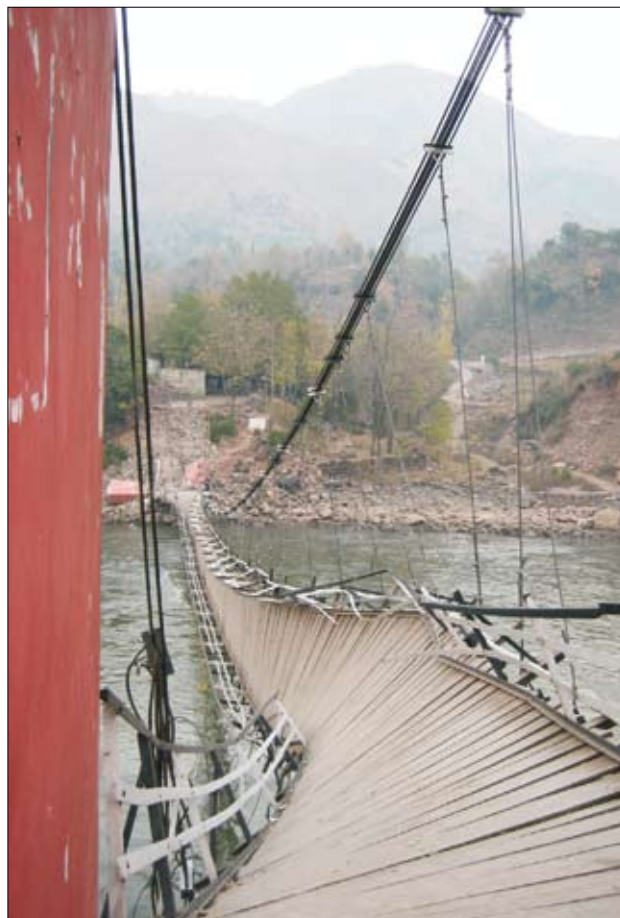
Sliki 23. Muzaffarabad: za prehod preko deroče reke Jhelum po visečem mostu, pri katerem se je med potresom na eni strani iztrgal kabel, je treba precej poguma.
