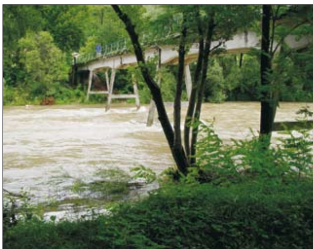
Slika 5. Izvajanje meritev z mostu. Zaradi varnosti se občasno uporabljata dve vrvi (foto: R. Trček)
