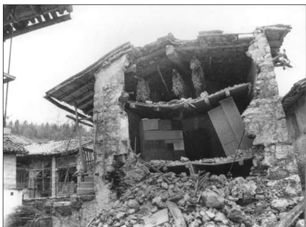
Slika 7. Ob potresih leta 1976 z žarišči v Furlaniji so bile najbolj poškodovane zgradbe iz neobdelanega kamna, povezanega s slabo apneno malto.
