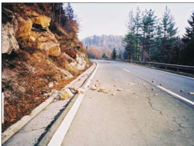
Slika 1. Dolenjska avtocesta – skalni okruški na dolenski avtocesti so se skotalili z brežine, ki je bila preko 20 let neproblematična in zato nezavarovana.
