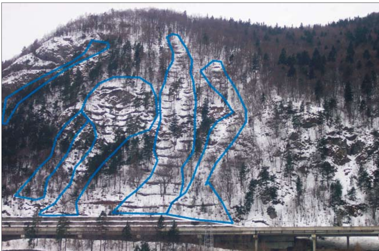
Slika 2. Fotografija pobočja Mežakle nad avtocesto Hrušica - Vrba decembra 2005 z označenimi območji, na katerih so varovalni objekti (foto: PUH)
