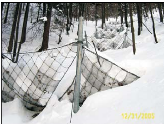
Slika 3. Sistemi varovanja s snežnimi mrežami na Mežakli preprečujejo proženje snežnih plazov
