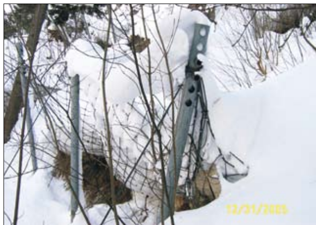
Slika 4. Izvedeni oporni objekti so ustvarili pogoje za uspešno rast sadike grmovnic in dreves, ki bodo v obnovljenem gozdnem sestoji dolgoročno prevzela trajno varovalno vlogo pred snežnimi plazovi na tem območju.
