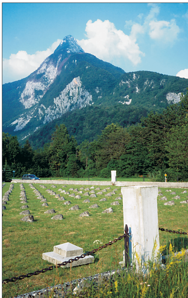
Slika 20. Na vojaškem pokopališču iz I. svetovne vojne na križišču cest proti Bovcu, Predelu in Vršiču je bila kamnita ograja v celoti poškodovana. Nihanje tal je povzročilo, da je odpadla vsaka druga plošča na stebru ograje.
