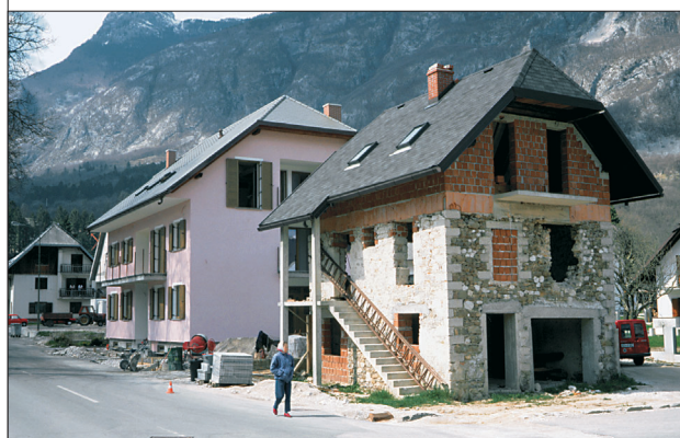
Slika 17. Popolnoma uničena hiša v Mali vasi v Bovcu (zgoraj) po potresu leta 1998 ni bila obnovljena. Spodnji del hiše je bil zgrajen iz neobdelanega kamna v slabi apneni malti (spodaj).
