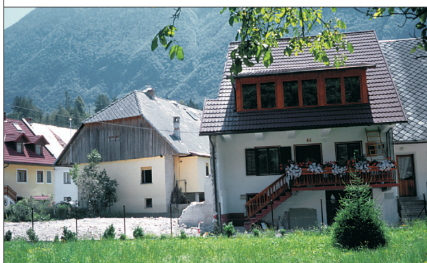
Slika 16. Zaradi lokalnih seizmogeoloških razmer so bile ponekod poškodbe nenavadne. Primer v Čezsoči kaže dve hiši, ki sta bili zgrajeni skupaj; leva je bila ob potresu uničena in so jo morali porušiti (zgoraj), desna pa je potres sorazmerno dobro prestala (spodaj).
