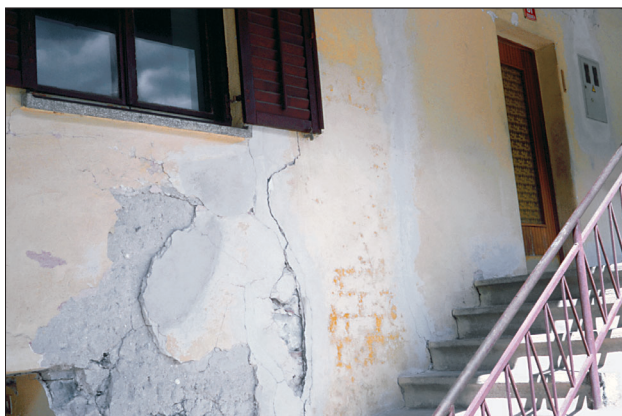
Slika 11. Odpadli omet na zgradbi v Čezsoči, ki je bila obnovljena po potresu leta 1998.
