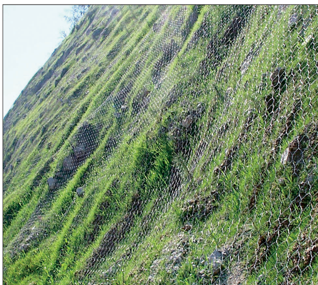
Slika 9. Uspešna zatravitev z rastno pulpo Figure 9. Successful grassing with hydroseeding
