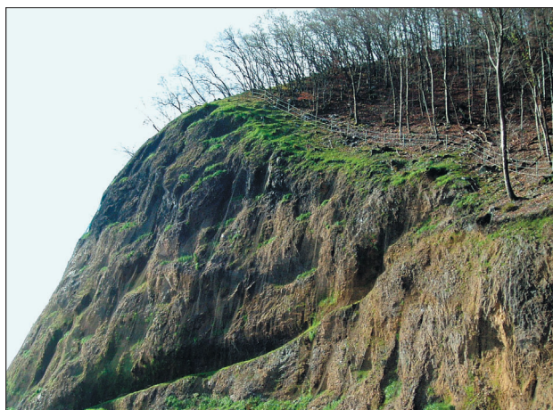
Slika 8. Jesen 2004 – zgornji rob brežine – zaoblitev, zavarovanje z mrežo in varovalno ograjo, zatravitev in zasaditev
