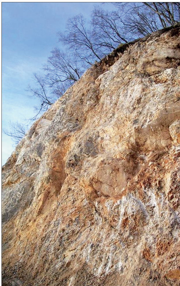
Slika 3. Zgornja brežina – nagib 75°, višina 40 m Figure 3. Upper bank – inclination 75°, height 40m
