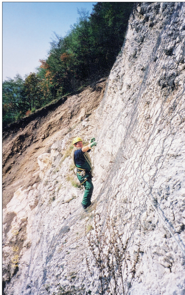
Slika 4. Zaščita brežine z mrežami Figure 4. Bank protection with nets
