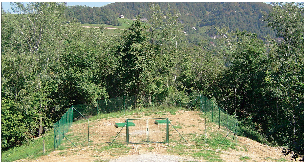
Slika 1. Pogled na potresno opazovalnico Črni Vrh nad Polhovim Gradcem. V seizmičnem jašku sta senzor in zajemalna naprava, v pomožnem jašku pa usmernik, akumulator za napajanje instrumentov in komunikacijska oprema (foto: P. Sinčič).
