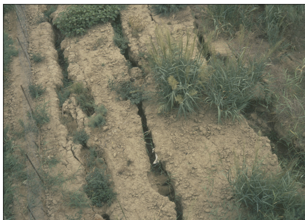
Slika 25. Alžir in Zemmouri – Razpoke v tleh, ki so lahko posledica likvefakcije [foto: R. Vidrih]. Figure 25. Algiers – Zemmouri: soil cracks which could be the result of liquefaction [photo: R. Vidrih].
