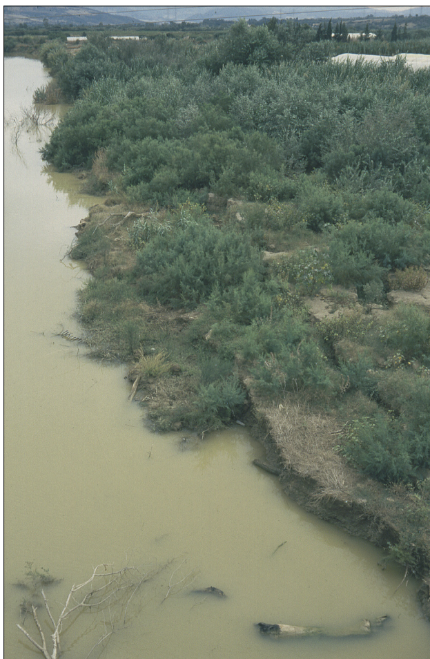
Slika 24. Alžir in Zemmouri – Pogled na lokalno porušitev tal, ki je povzročila plazenje [foto: R. Vidrih]. Figure 24. Algiers – Zemmouri: landslide [photo: R. Vidrih].
