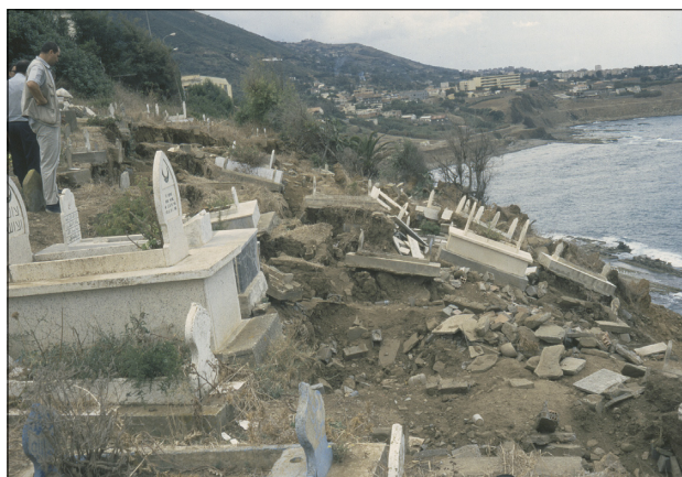
Slika 12. Zemmouri – Razdejanje na pokopališču je bilo posledica dviga tal (foto: R. Vidrih).
