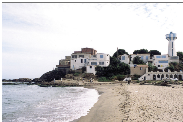
Slika 10. Zemmouri – V starem delu majhne ribiške vasice ni bilo večjih poškodb, kljub temu da so bili objekti slabo zgrajeni. Razlog je v tem, da je ta del mesta zgrajen na skali (foto: M. Godec).
