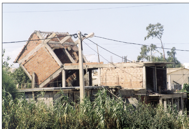
Slika 14. Zemmouri – Še tako dobra gradnja na trhli osnovi ne zagotavlja varnosti. V tem primeru se je porušilo vozlišče (foto: M. Godec).
