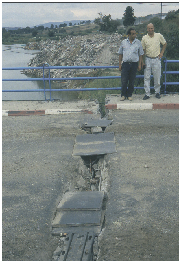
Slika 23. Alžir in Zemmouri – Detalj poškodbe na mostu, ki je nastala ob razširitvi (foto: R. Vidrih).
