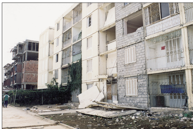
Slika 4. Boumerdes – Pogled na stanovanjske bloke v naselju, ki je bilo zgrajeno po letu 1962. Gre za tehnologijo, ki so jo v tistem času uporabljali v Sovjetski zvezi (foto: M. Godec).
