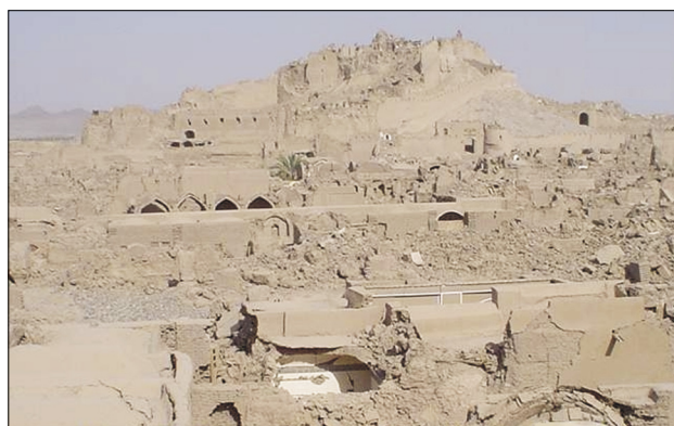
Slika 18. Bam. Značilen pogled na popolnoma uničene dele mesta, kjer je vse grajeno iz na zraku sušene opeke.
