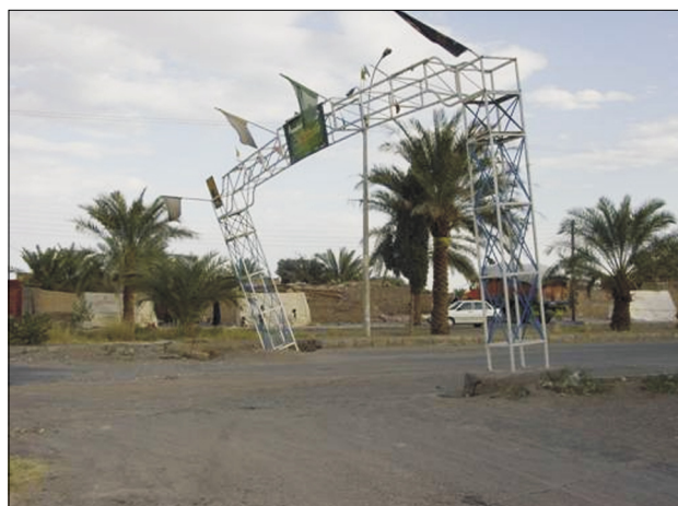
Slika 14. Poškodba znaka zaradi porušenja sistema »qanats« v Baravatu Figure 14. Damage to a sign due to the collapse of a Qanat (Baravat)
