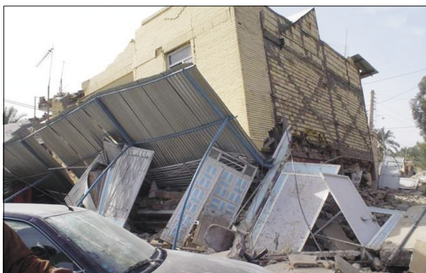
Slika 21. Bam. Značilna porušitev zgradbe s tako imenovanim mehkim pritličjem. Pritlični odprti del je služil za garažo, nad njim pa je masivna konstrukcija.
