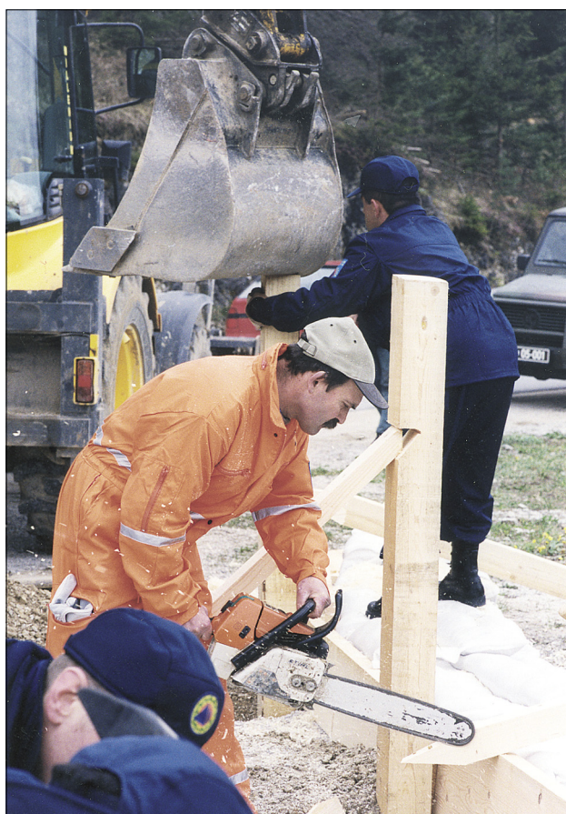
Slika 4. Gradnja nasipa s pomočjo lesa in delovnih strojev (foto: J. Oražem) Figure 4. Constructing embankments using wood and machinery (photo: J. Oražem)
