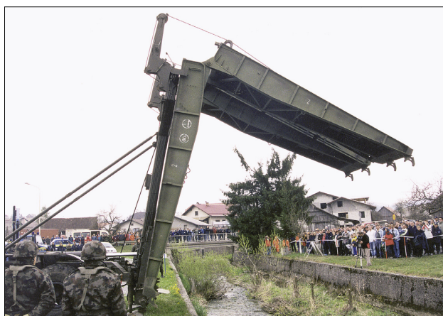
Slika 11. Postavitev lansirnega mostu s strani 14. inženirskega bataljona SV (foto: J. Oražem)
