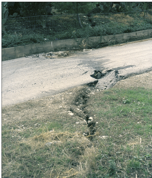
Slika 10. Pretrg je presekal cestišče, kjer se je ena stran plazišča pogreznila za 20 do 30 cm (foto: R. Vidrih).
