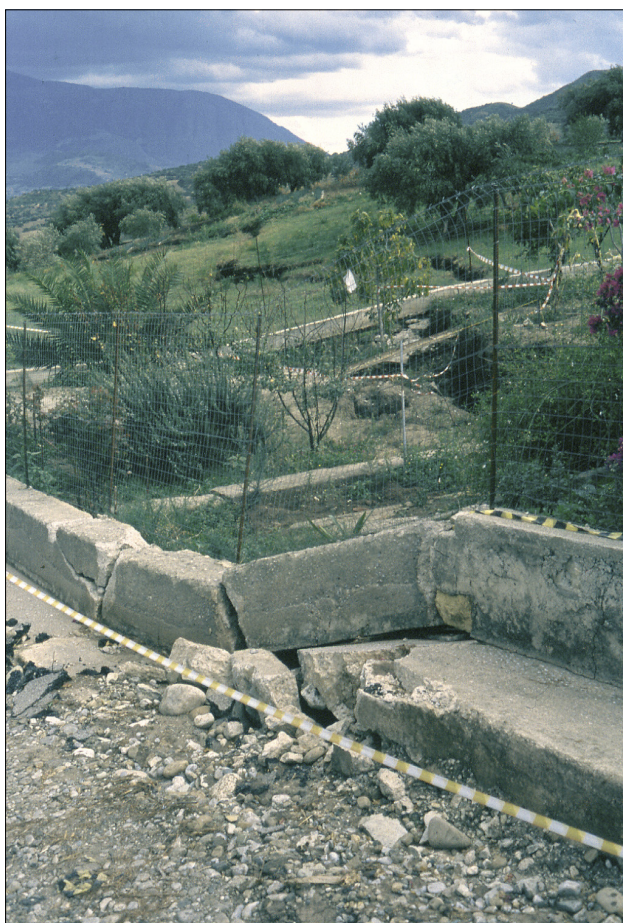
Slika 13. Detajl premaknjenega mostu (foto: R. Vidrih).
