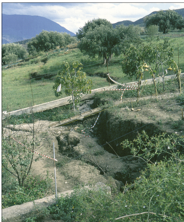
Slika 7. Detajl razpoke. Poškodbe na plazu (foto: R. Vidrih).
